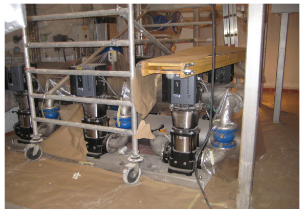
Risiko for forureninger i forbindelse med reoveringssarbejder på et vandværk
