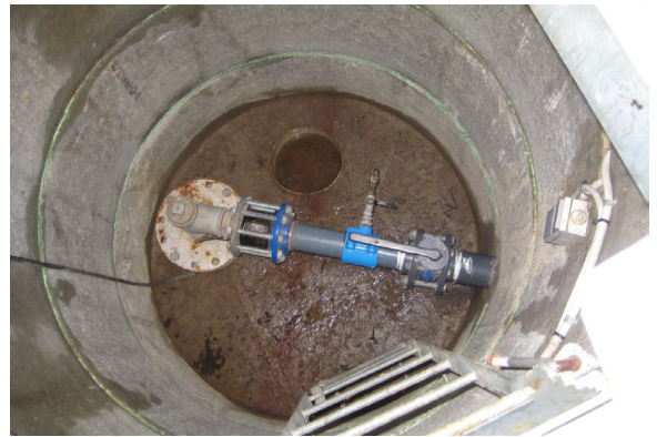
Indvindingsboring med tørbrønd – risiko for indsvivning af overfladevand og opstigende grundvand
